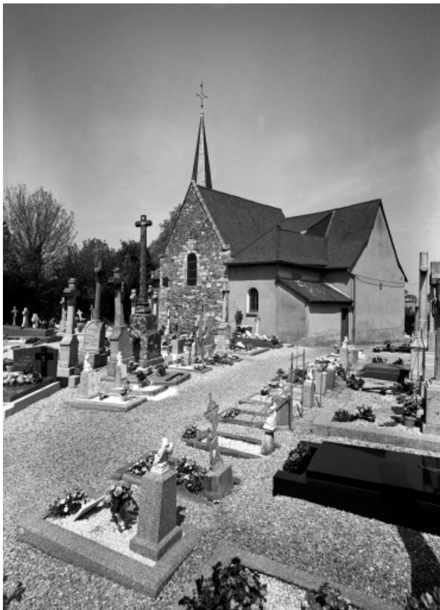
Vue depuis le sud-ouest (état en 1975)
