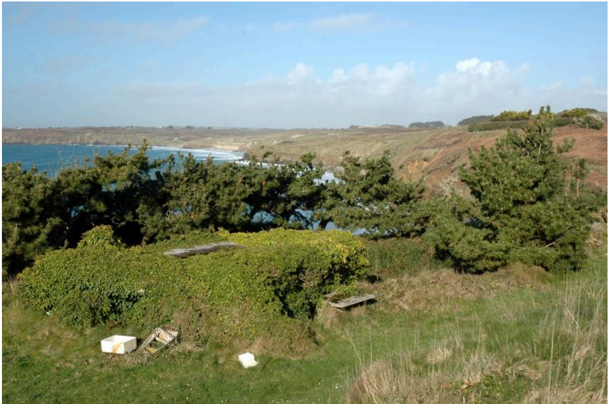
Vue des vestiges de la batterie de Treize et des bunkers
