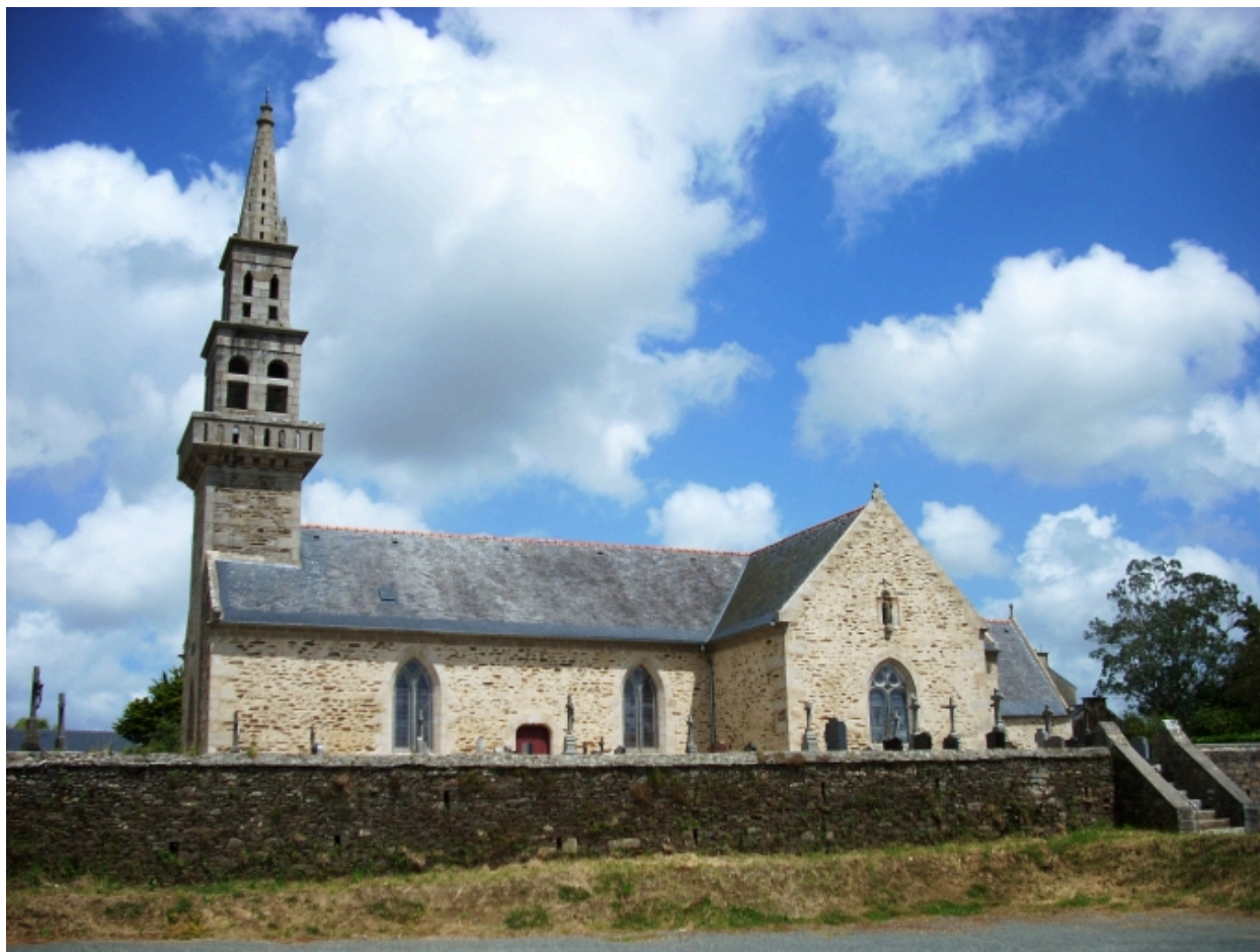
Lanarvily, église paroissiale : vue générale sud-ouest
