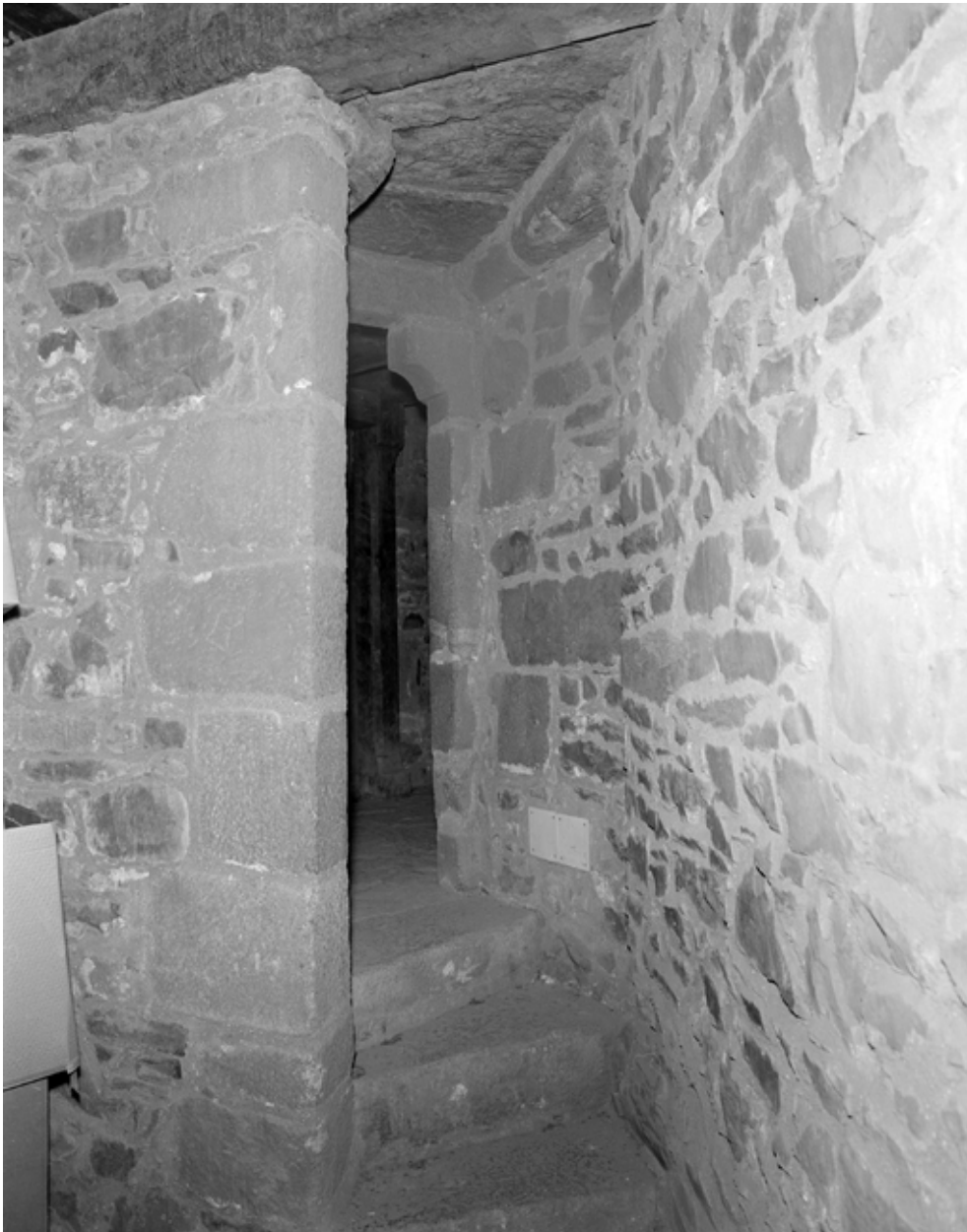
Vue du corps de garde du chemin de ronde : porte (état en 1974)
