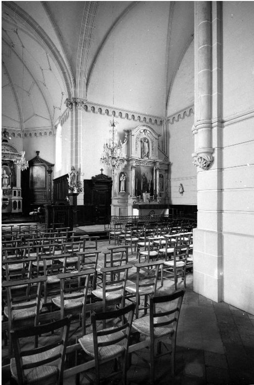
Intérieur : vue générale du bras sud du transept, vue prise du nord-ouest (Etat en 1968)
