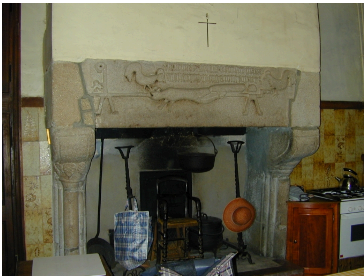
Logis, intérieur, cheminée de la cuisine : vue générale
