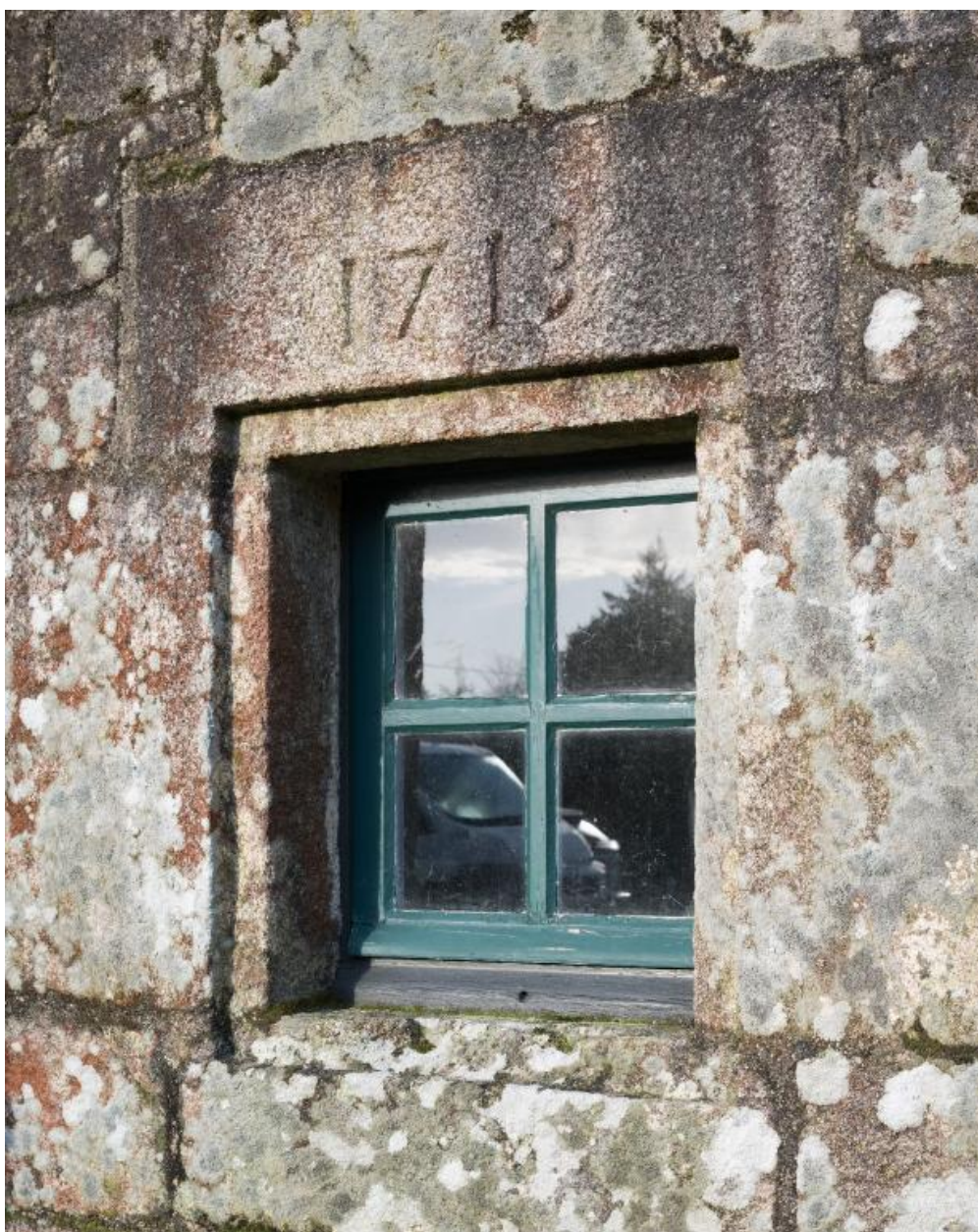
Vue de détail : fenêtre de la façade est de la sacristie.
