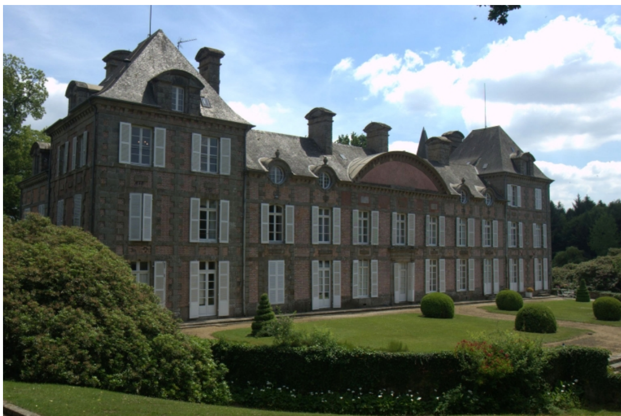
Vue générale façade nord
