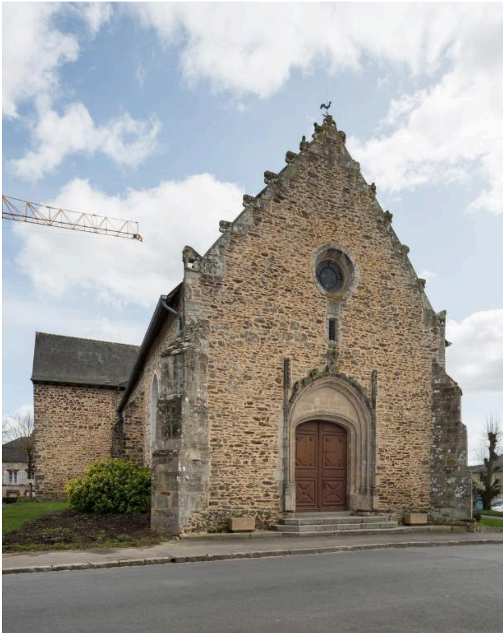
Elévation ouest et portail
