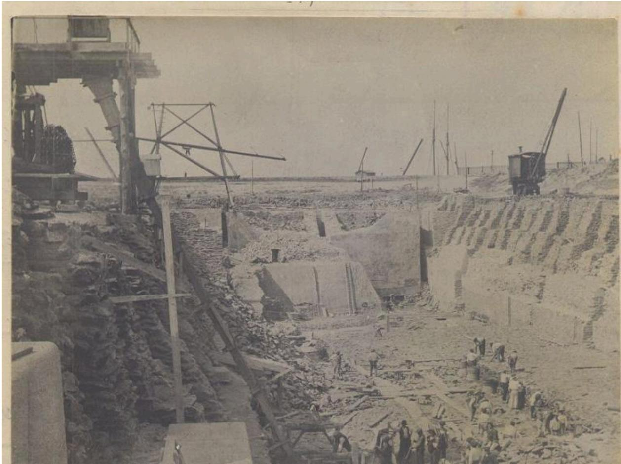
Travaux de la forme de radoub n°1 : reprise en sous-oeuvre du bloc 38 de fondation
