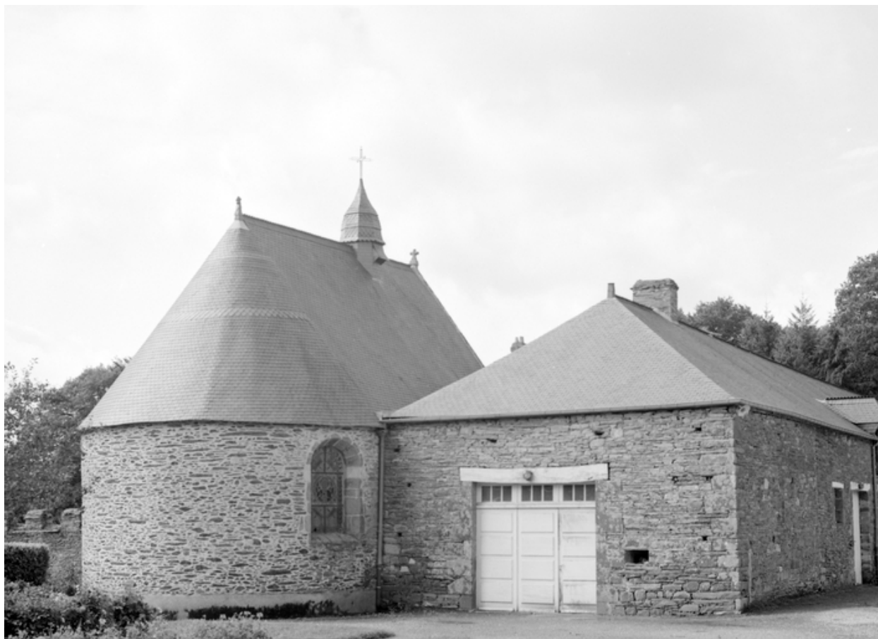
Chapelle : vue générale prise du nord-est
