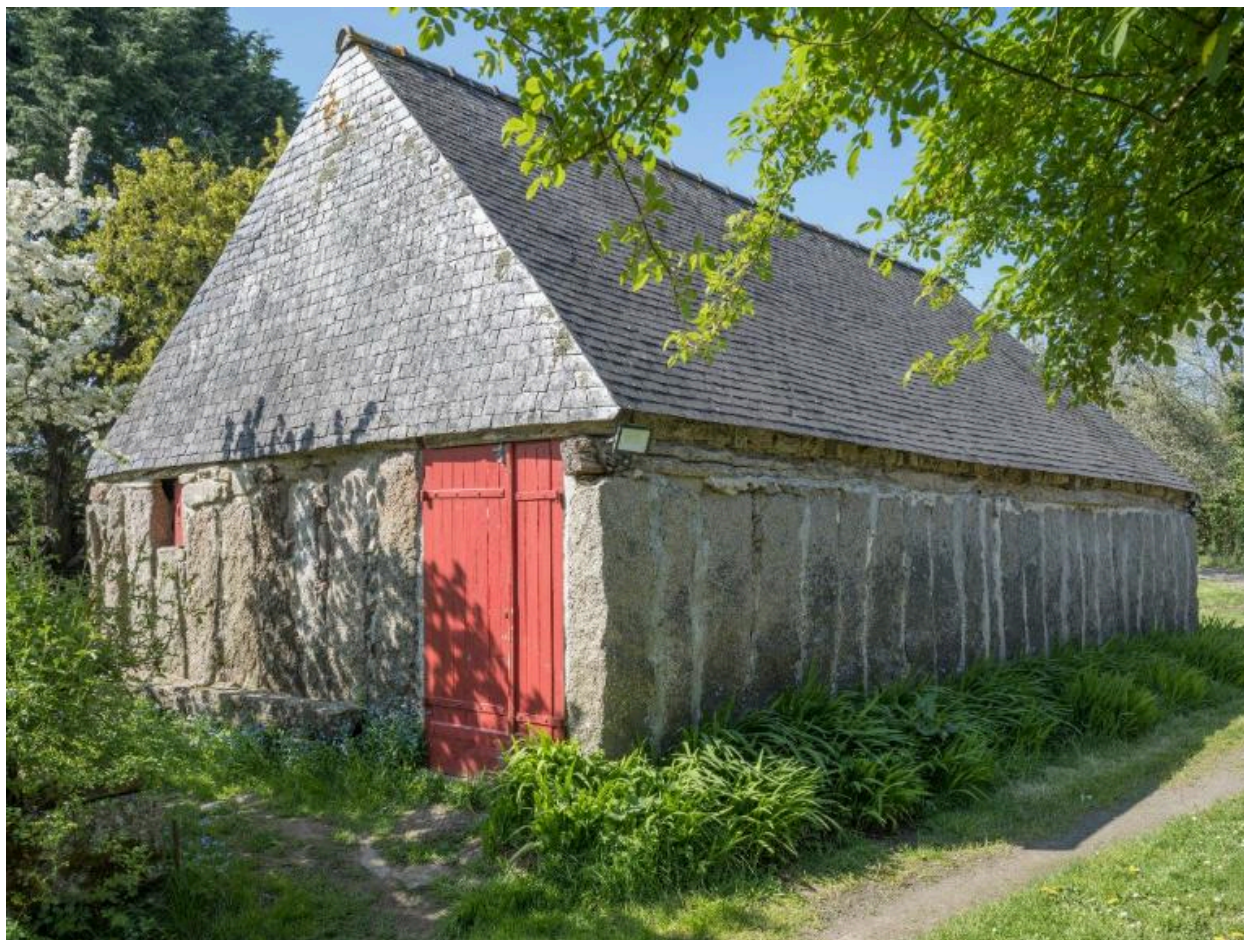
Vue générale de la grange.
