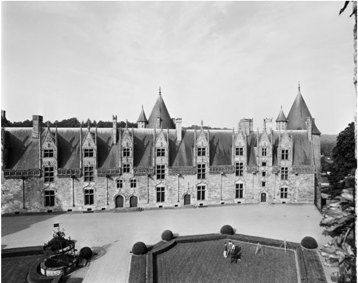
Logis, élévation sur cour : partie nord
