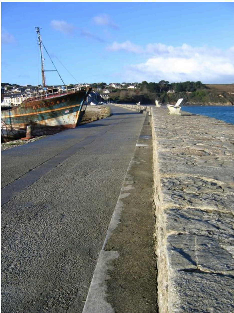
Vue générale de la digue-route du Sillon
