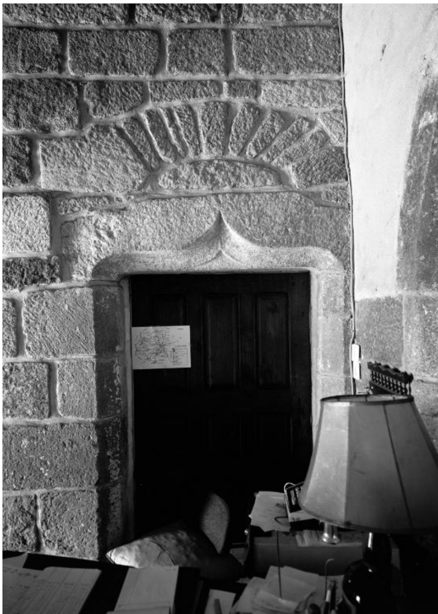
Couloir d'entrée, porte à arc de décharge sur le mur de refend ouest
