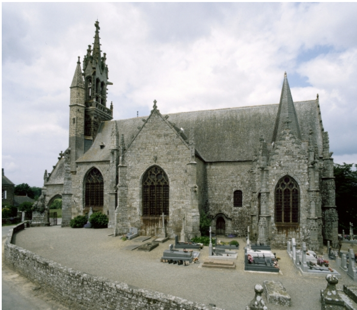
Elévation sud, partie est : vue générale
