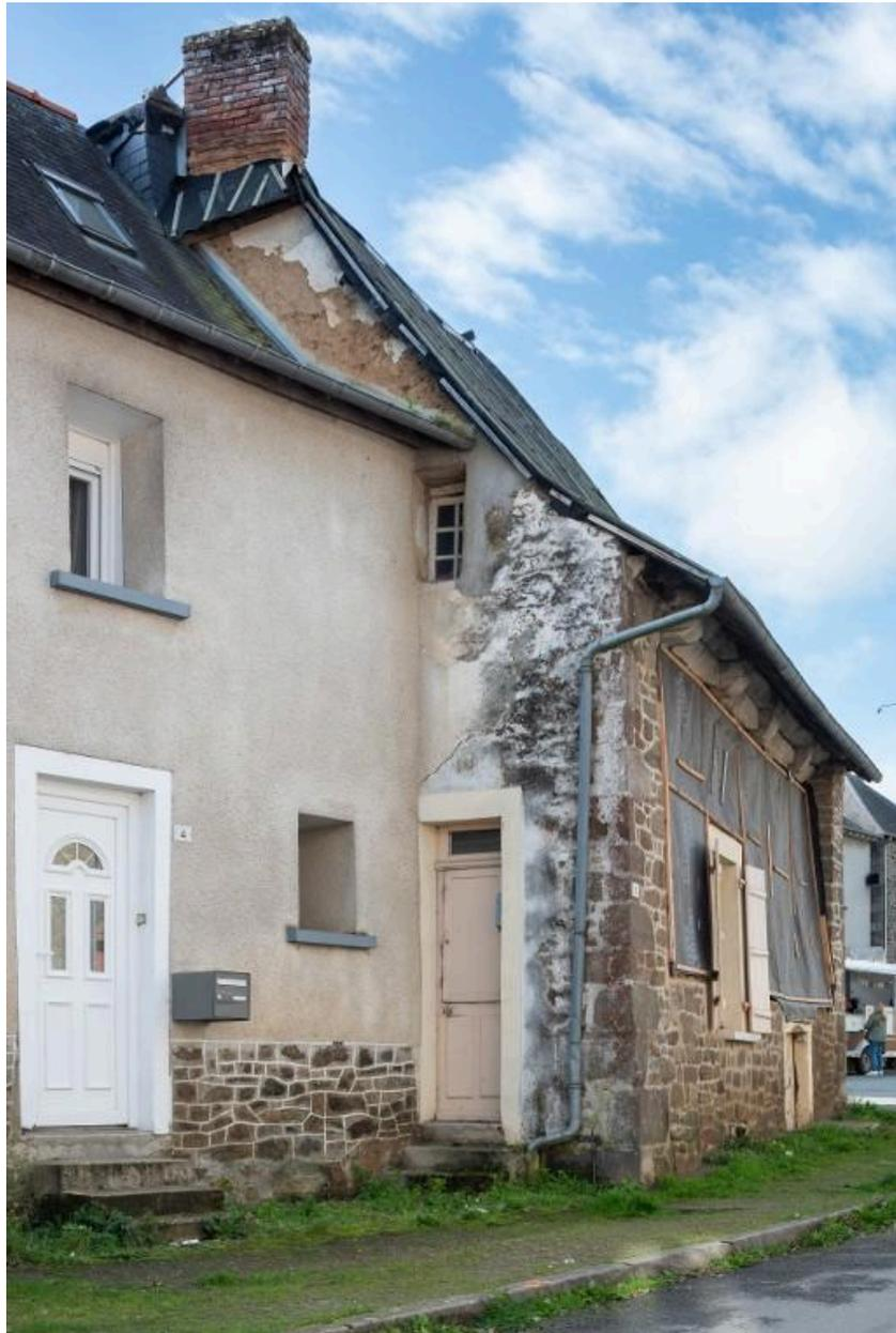
Bâtiment construit en maçonnerie, pan de bois (caché par les bâches) et terre pour les pignons.
