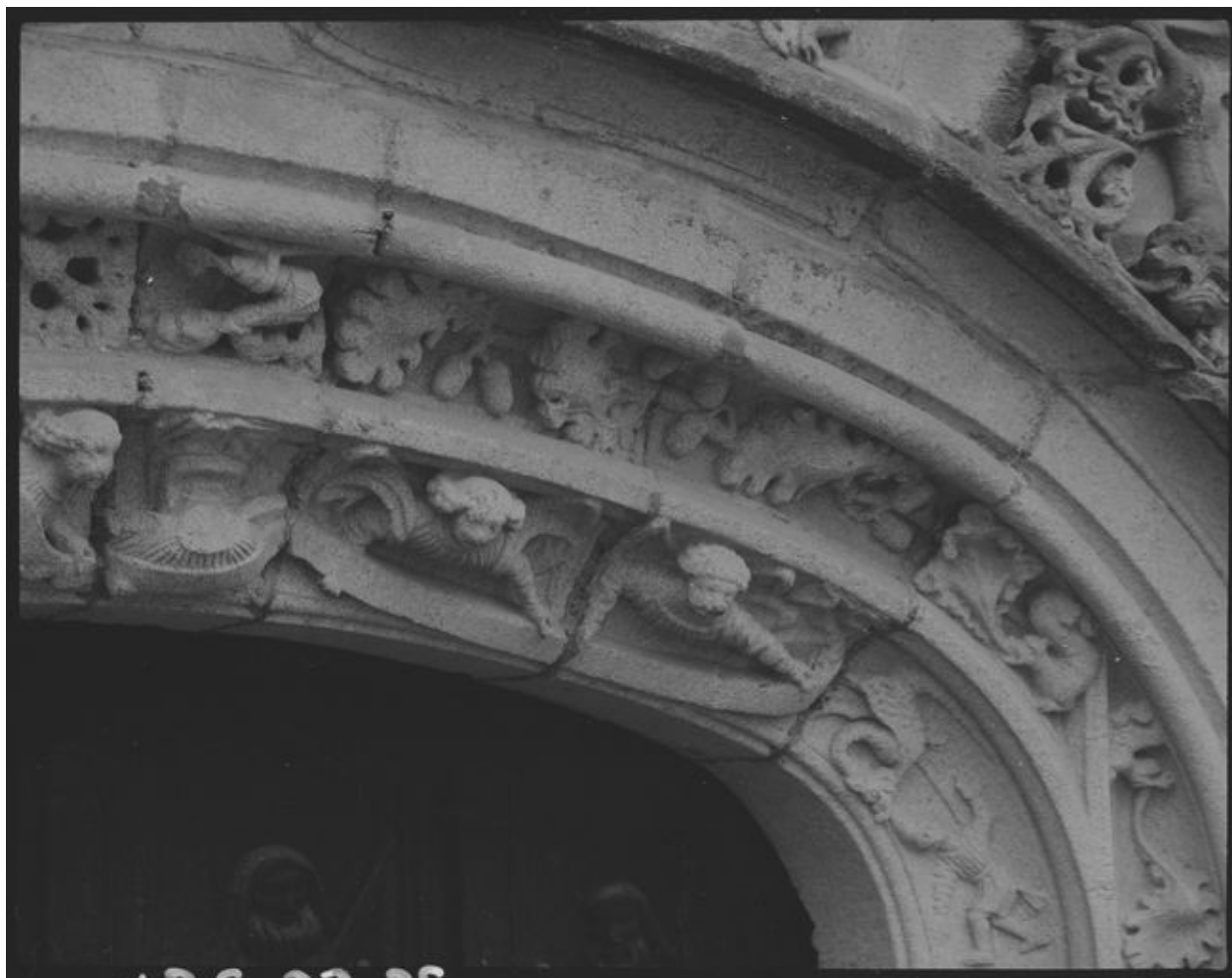
Porche nord, gauche, détail de l'arc
