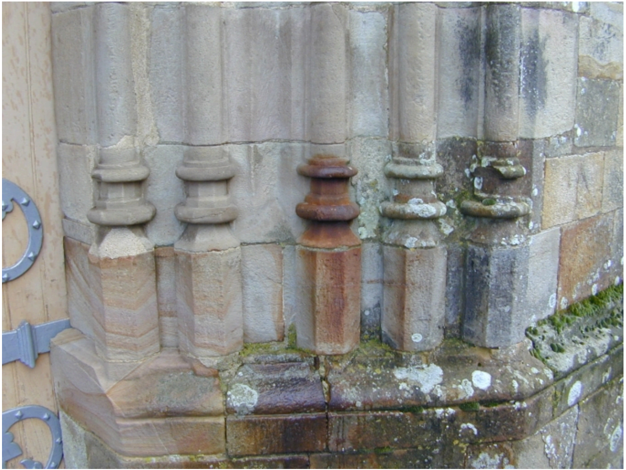
Façade ouest, portail, détail
