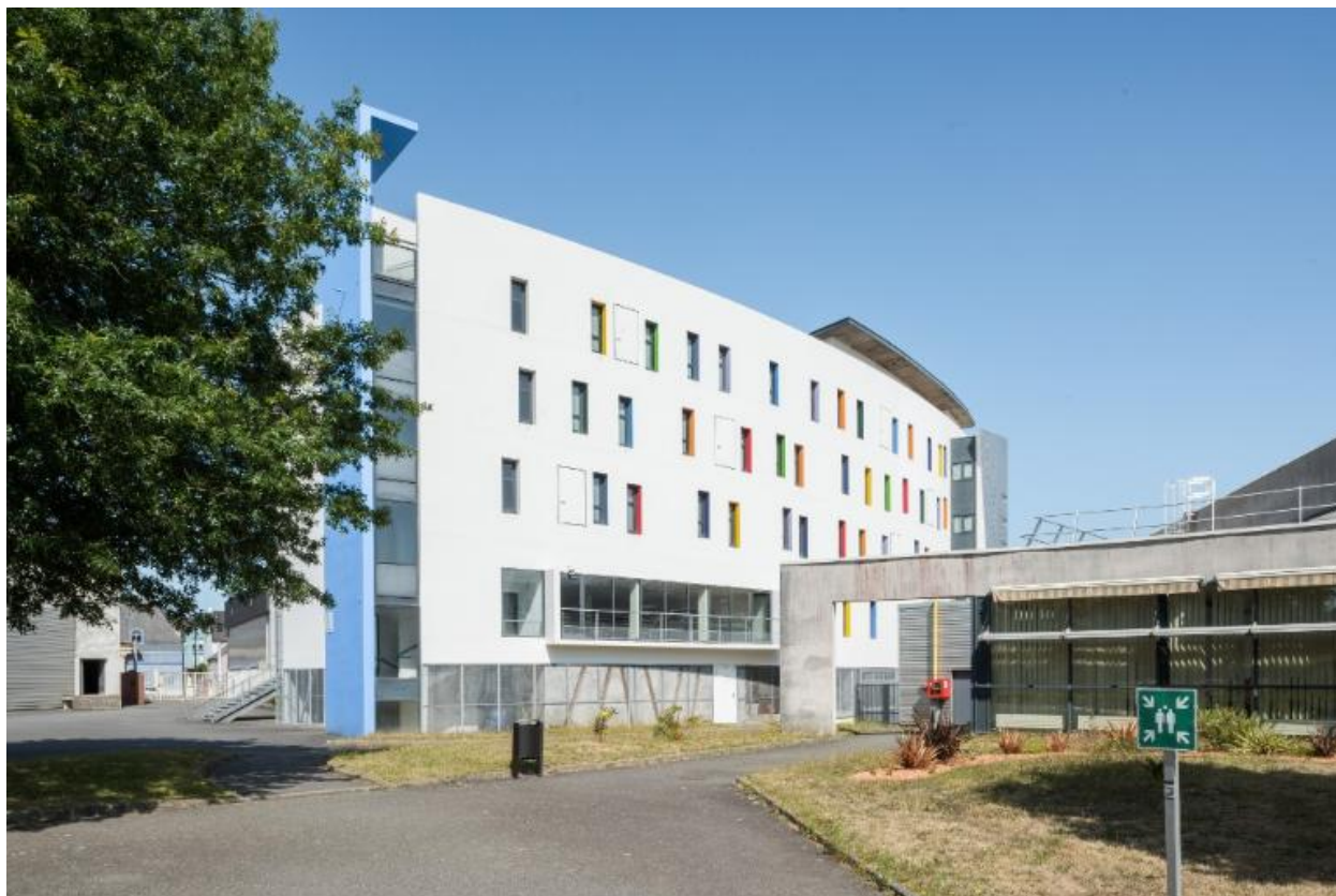
Internat : vue d'ensemble de la façade est. Agence Déesse 23, architectes, 2005-2006.
