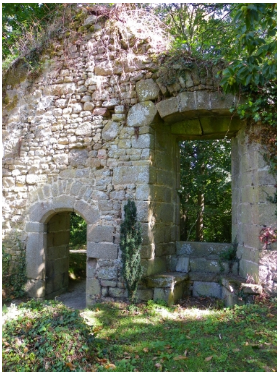
Chambre des Coëtlogon, anciennes porte et fenêtre, côté ouest.
