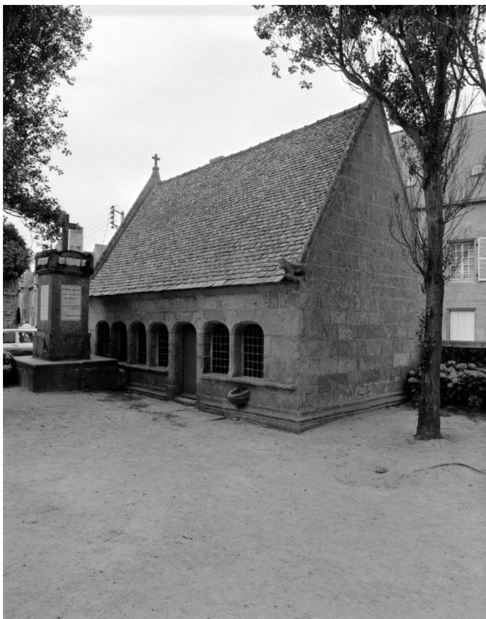
Ossuaire n°2, vue générale nord-est
