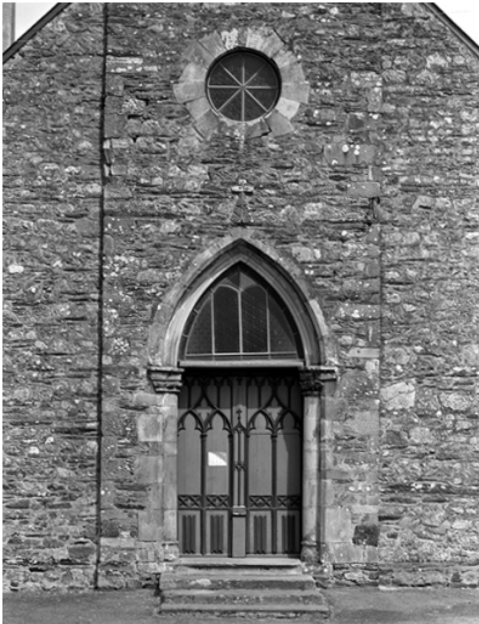
Arcature du 15e siècle employée en guise de porche : vue générale ouest
