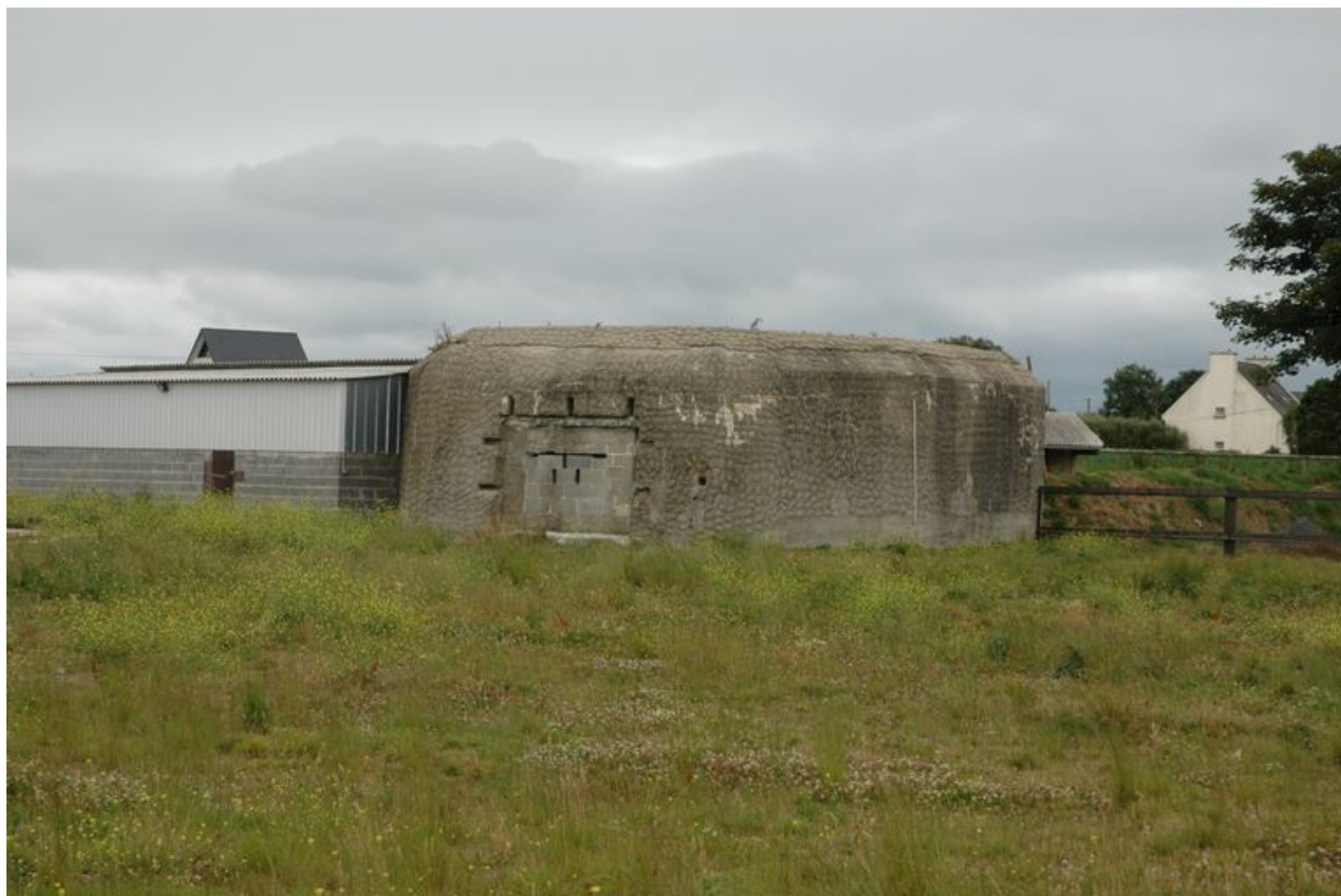
Vue générale du bunker-casemate nord côté embrasure (état en 2008)
