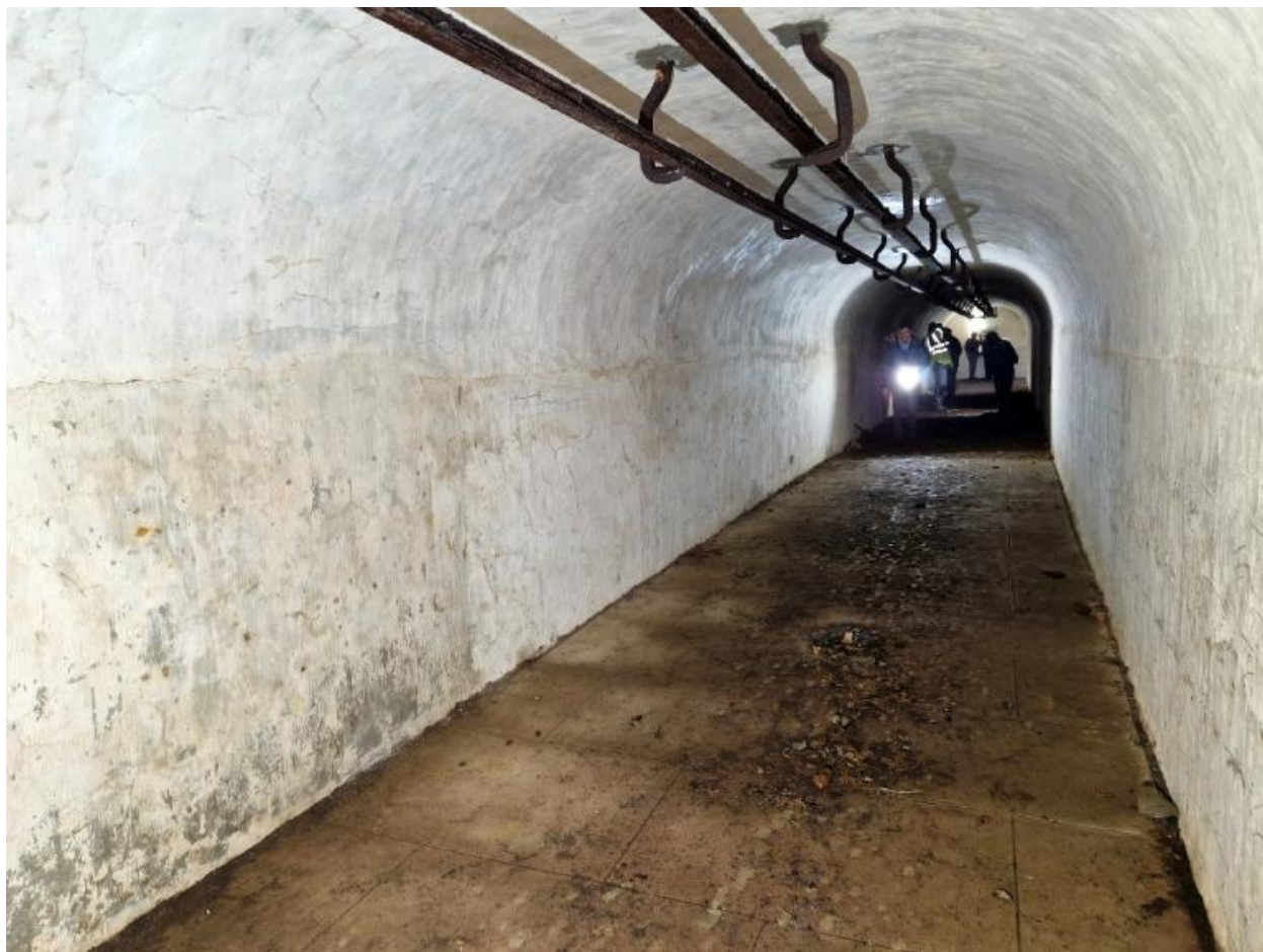
Vue intérieure du magasin à munitions : extrémité ouest, fixations et rail pour la manutention des obus via un palan. Photographie prise lors d'une sortie organisée par l'Association 1846
