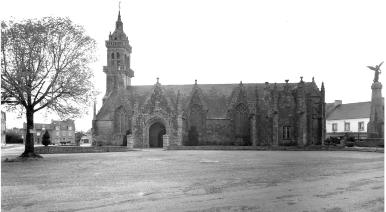
Plonévez-du-Faou, église paroissiale Saint-Pierre : vue générale sud, état en 1967
