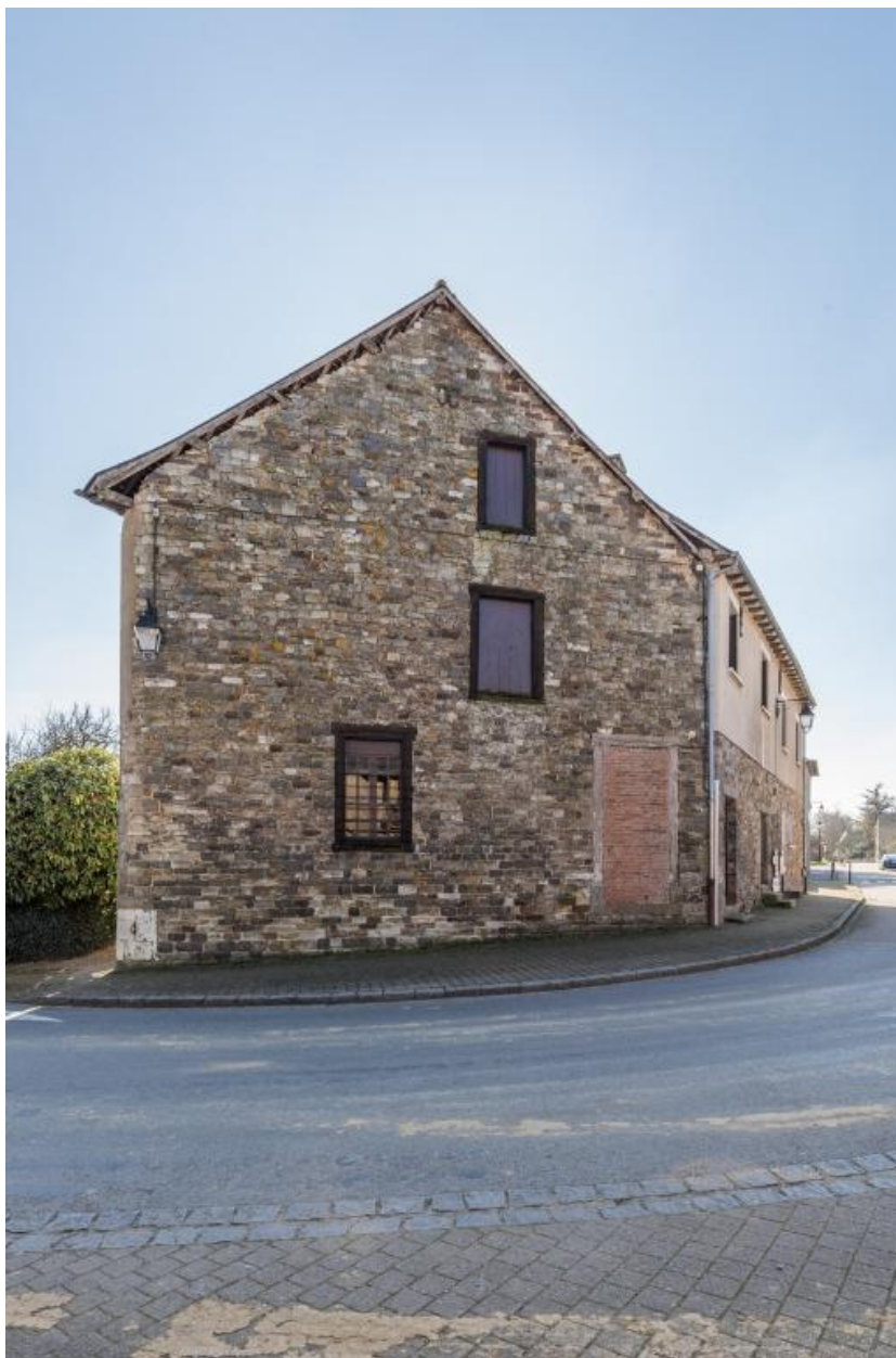
Ancienne auberge "A l'écu de France", mur nord
