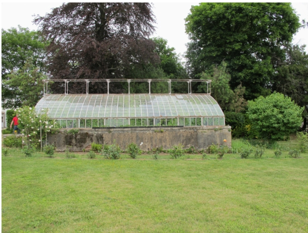
Serre de jardin, vue générale
