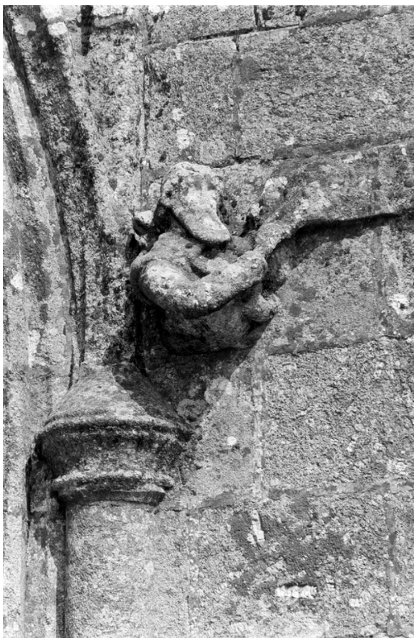
Clocher, face ouest, colonne sud de la porte : détail de la figure sculptée
