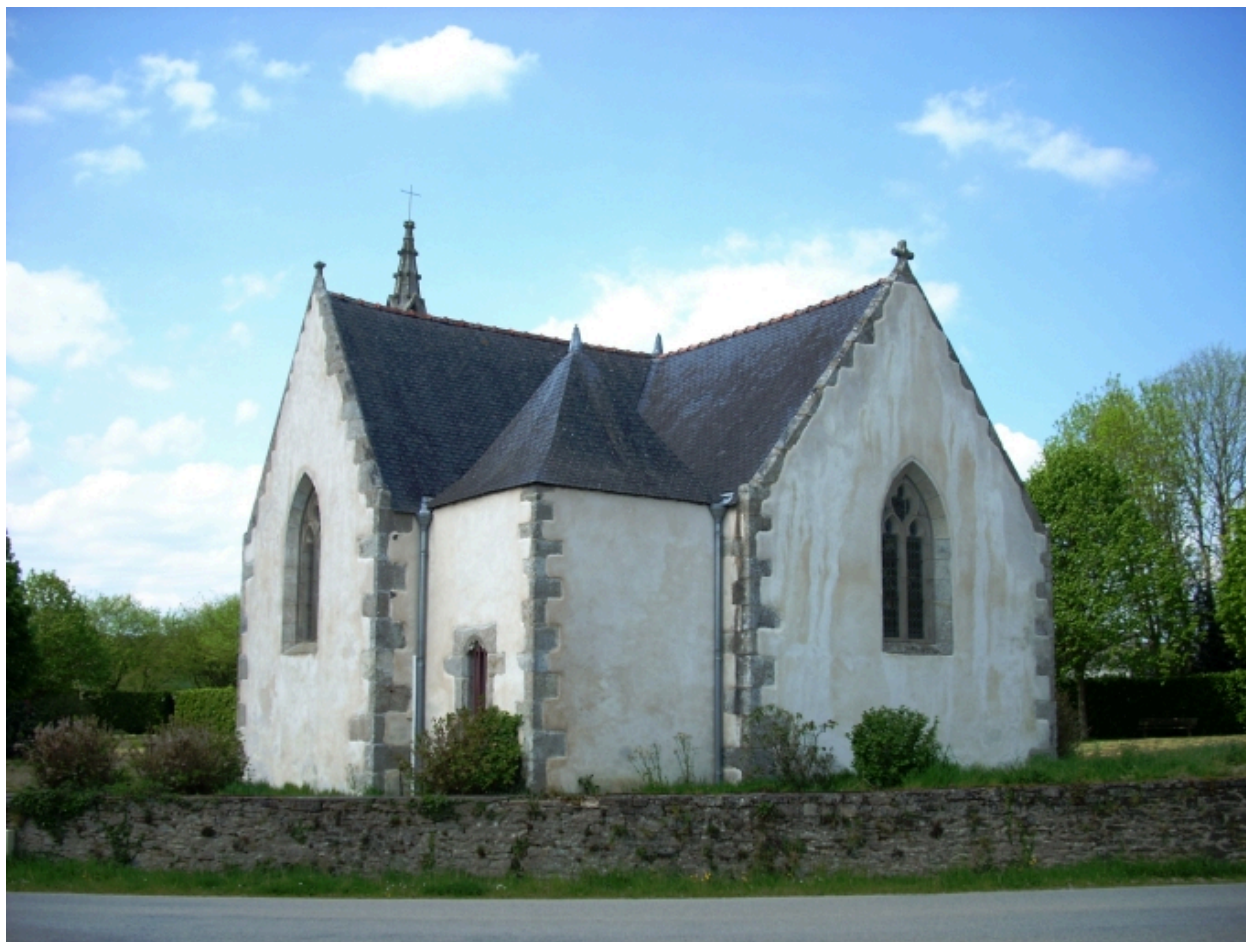
Collorec, chapelle Sainte-Marguerite : vue générale sud-est
