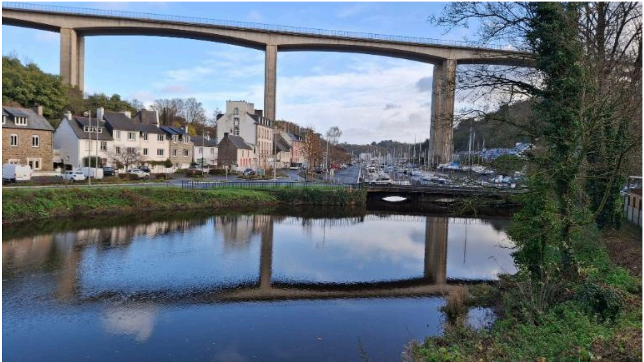
Le pont-de-pierre dans son environnement urbain, portuaire et naturel (en amont du Gouët)
