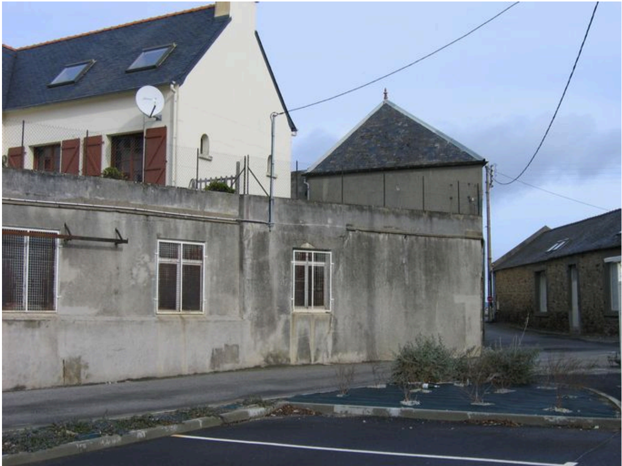
Elévation postérieure de l'ancienne conserverie
