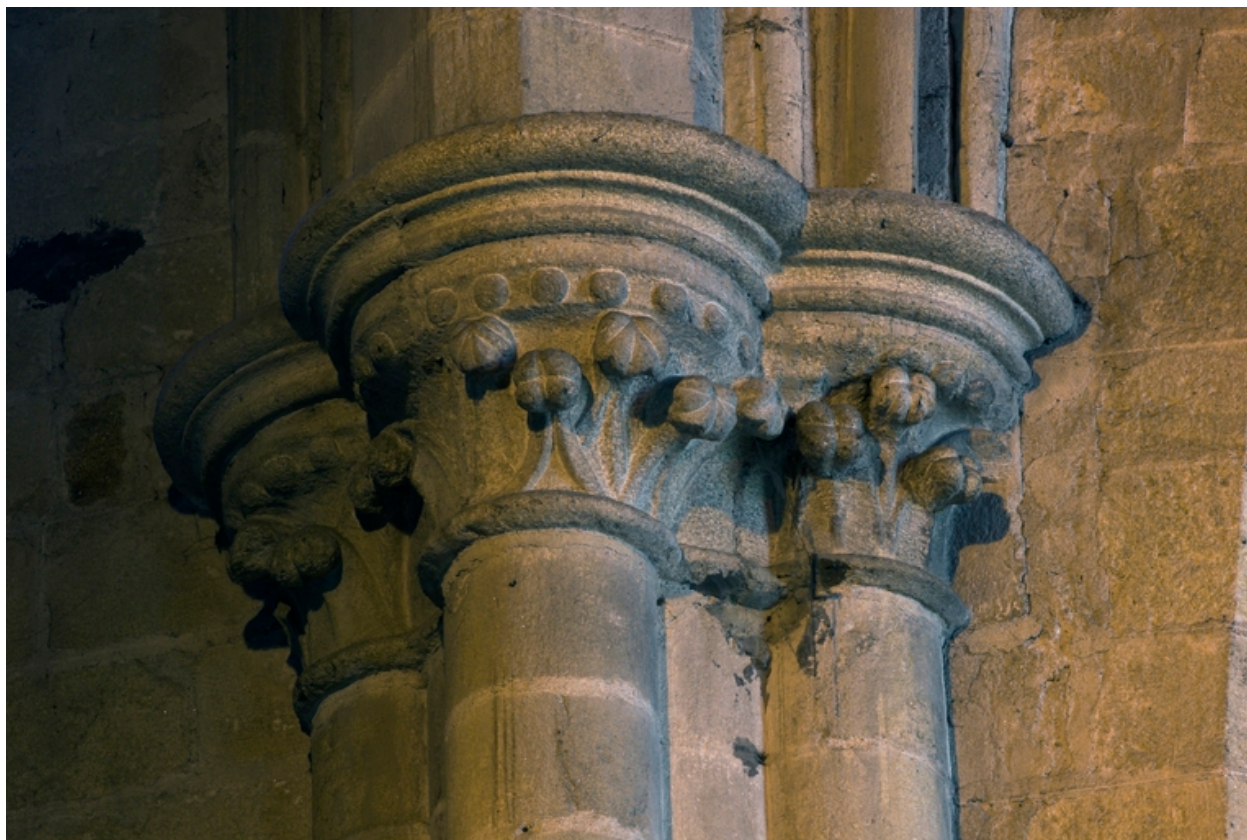
Chapiteaux des piles du choeur, collatéral sud
