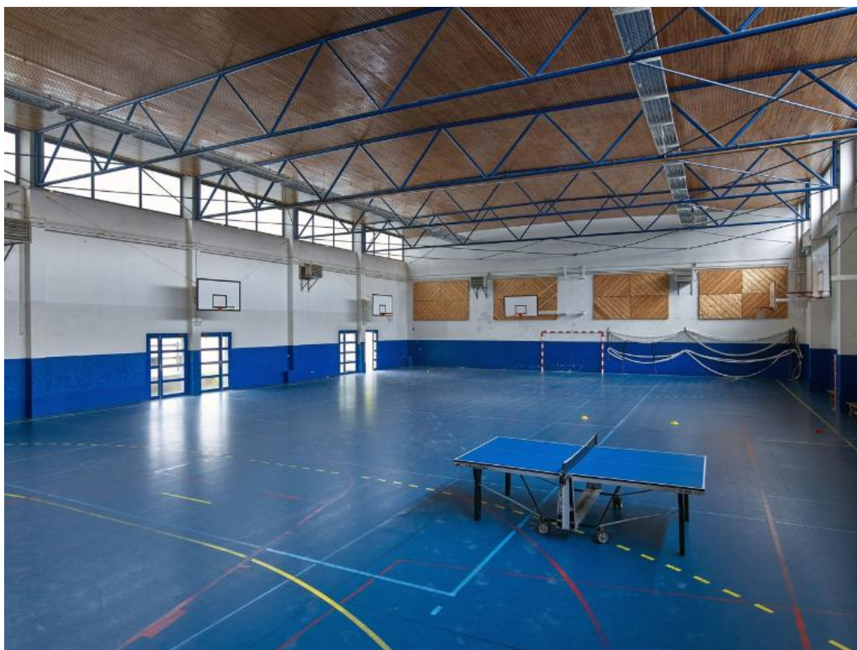
La salle de sports collectifs et sa charpente métallique, gymnase type B.
