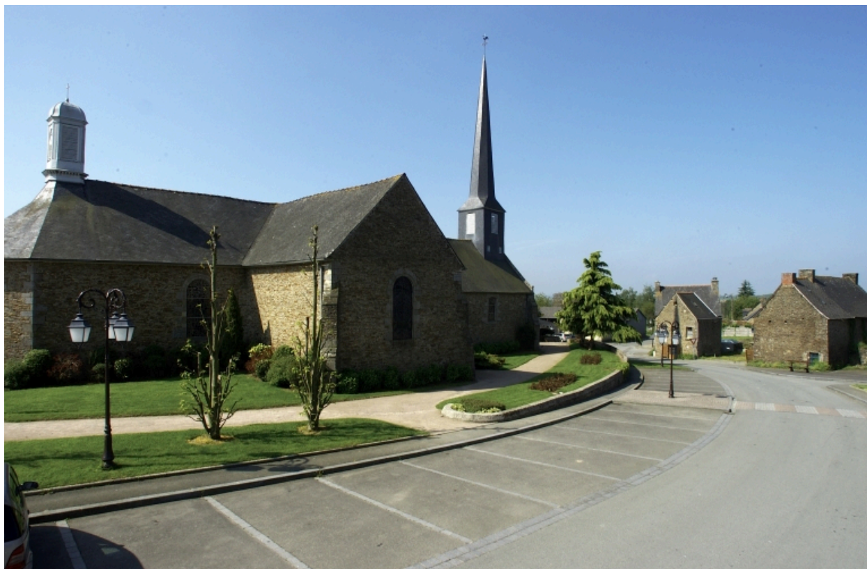
Vue de situation nord est
