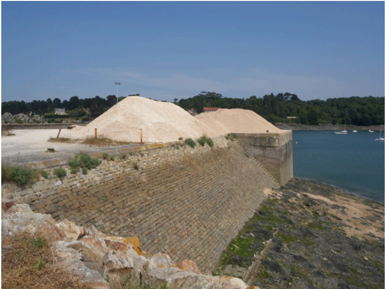
Vue du quai Sud-Ouest des sabliers
