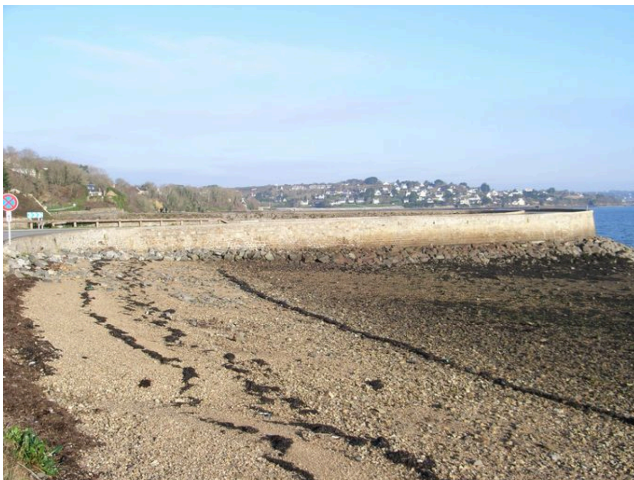
Vue vers le nord de la digue-route de Quéléren
