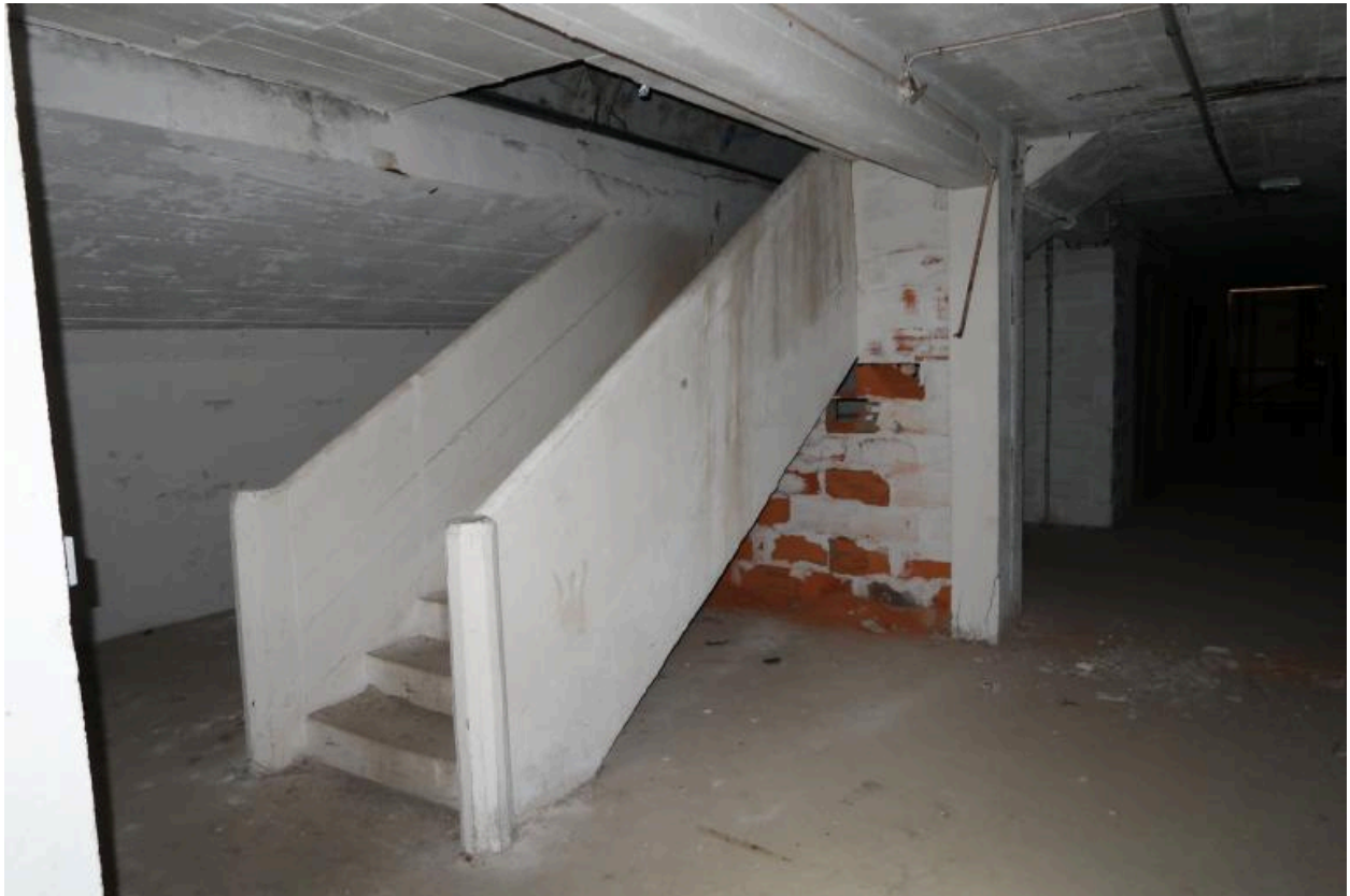
Troisième étage (quatrième niveau) : escalier droit donnant accès au quatrième étage (cinquième niveau)
