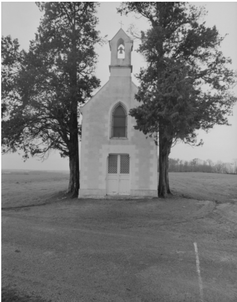
Elévation nord : vue générale
