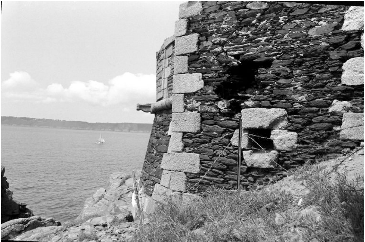
Vue de la batterie de Cornouaille en 1967 : extrémité ouest, escarpe, chaînes harpées en pierres de taille de granite
