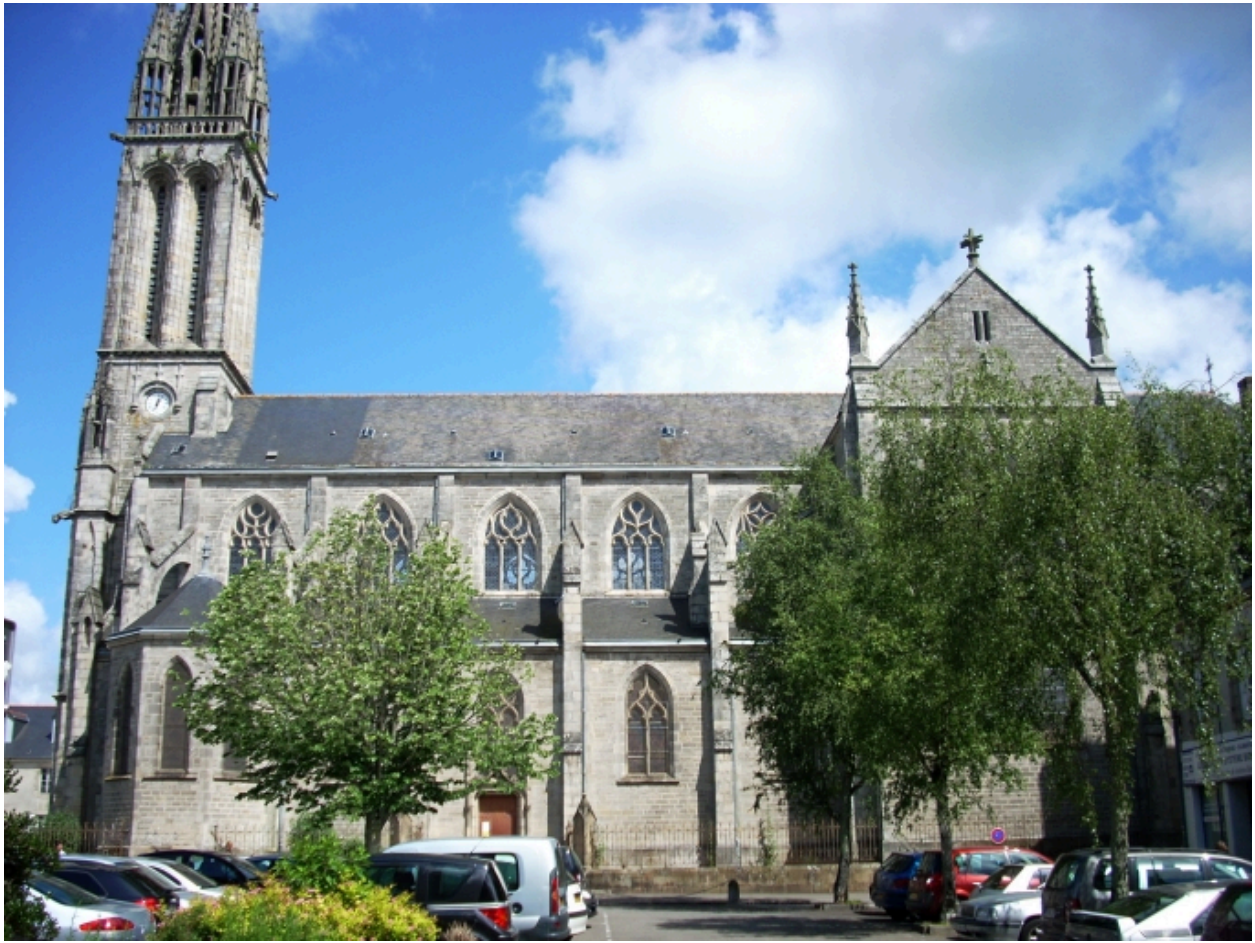
Quimper, église Saint-Mathieu : élévation sud
