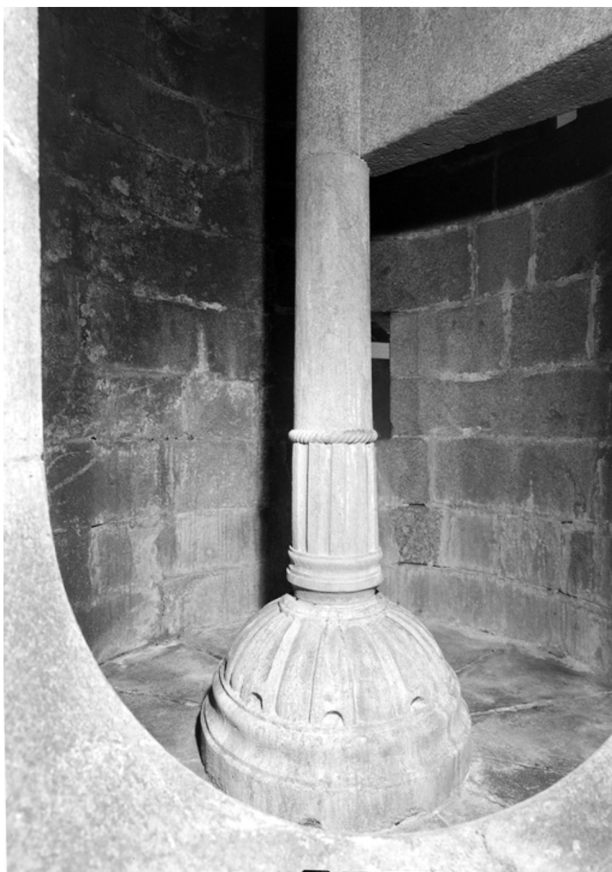
Escalier de la tour : poteau de l'escalier
