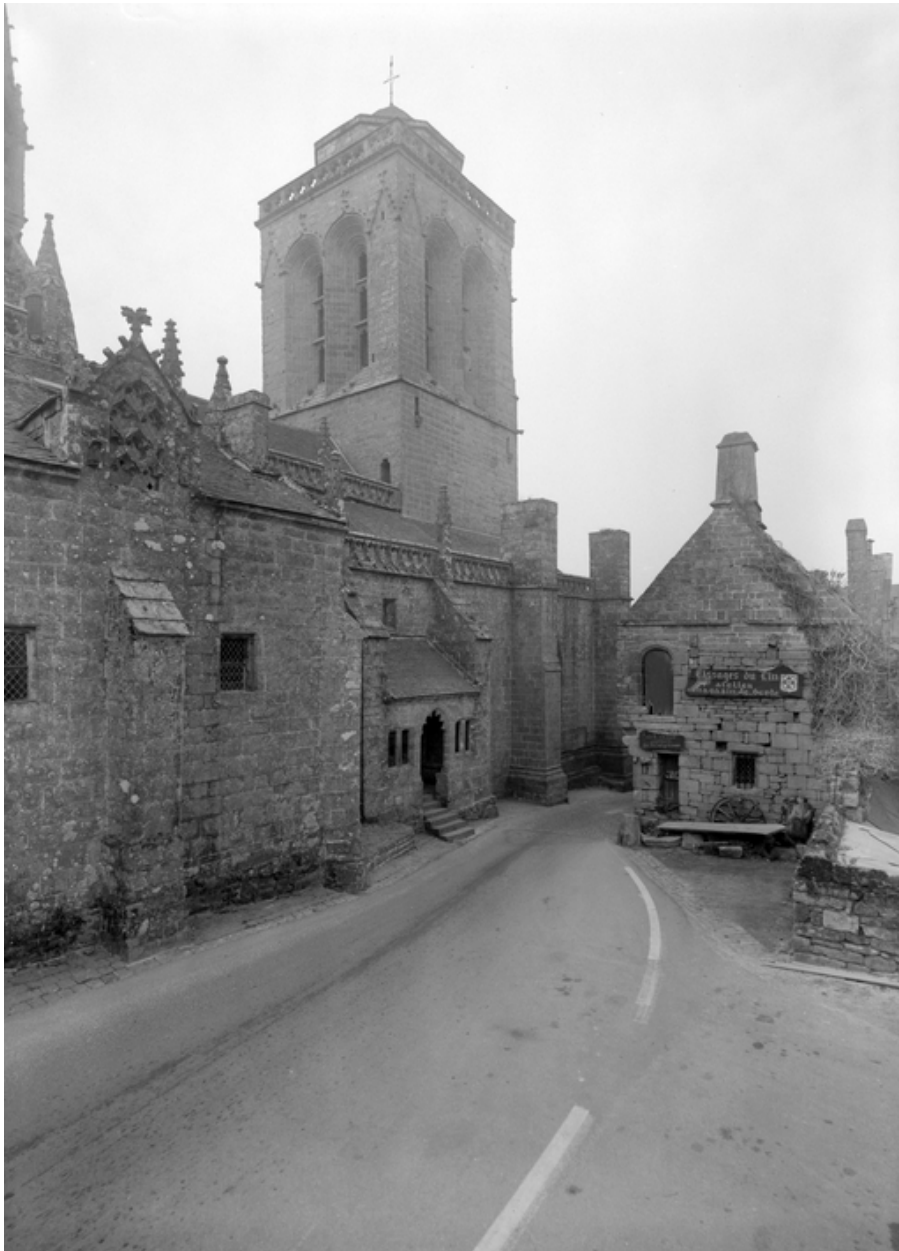
Façade nord, vue générale
