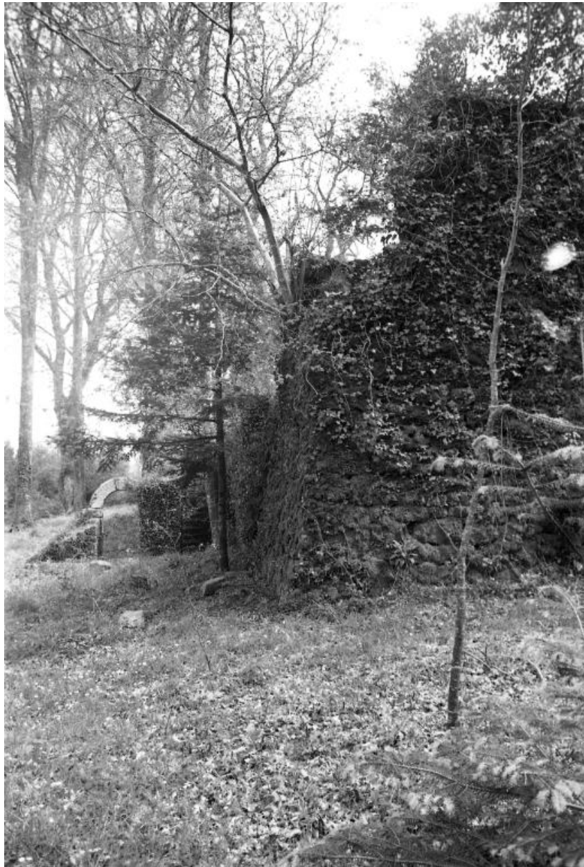
Ruines de l'ancien château - Vue de situation prise de l'ouest
