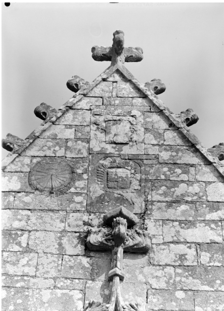
Façade sud, porche, détail des armoiries
