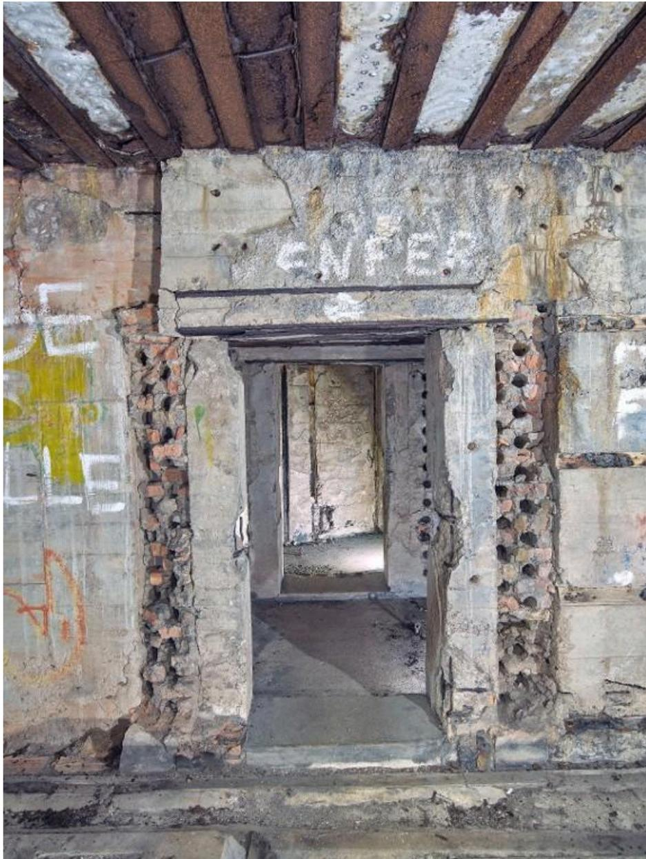
Vue du passage des câbles de la salle des compensateurs au puits d'antenne nord-est via un sas étanche. Ils sont photographiés depuis la salle des compensateurs ; au centre, porte disparue
