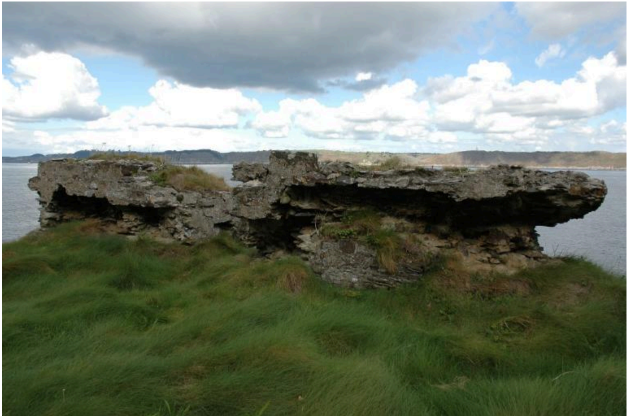
Vue des vestiges du parapet (état en 2005)
