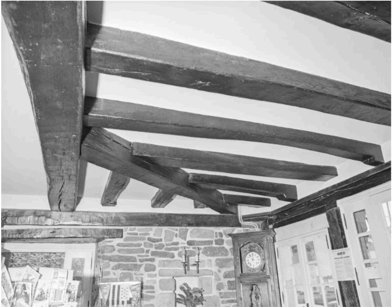
Intérieur, rez-de-chaussée, système de poutraison dans l'angle nord-ouest.
