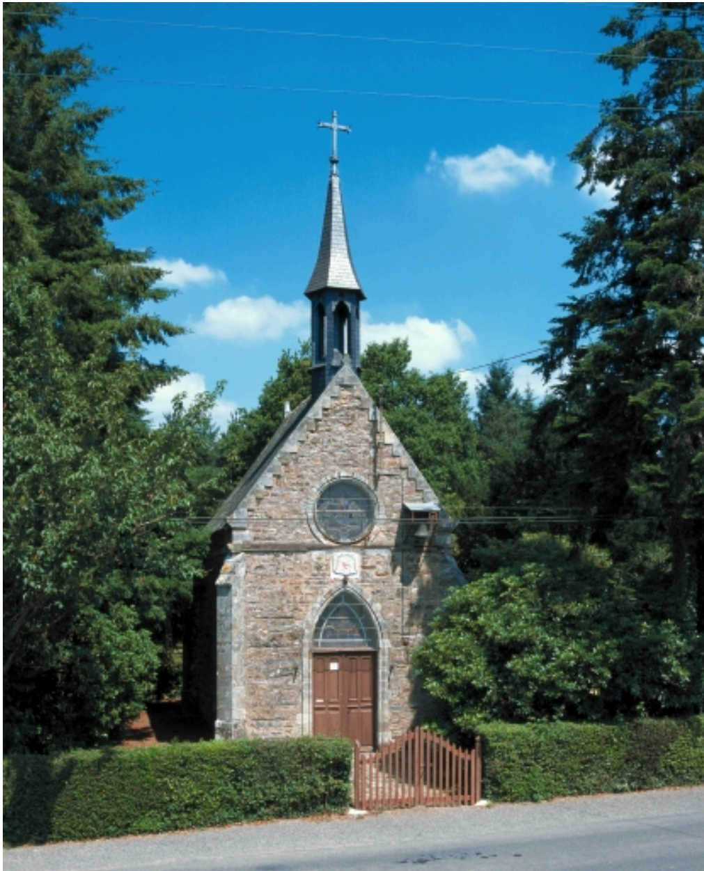
Façade : vue générale sud
