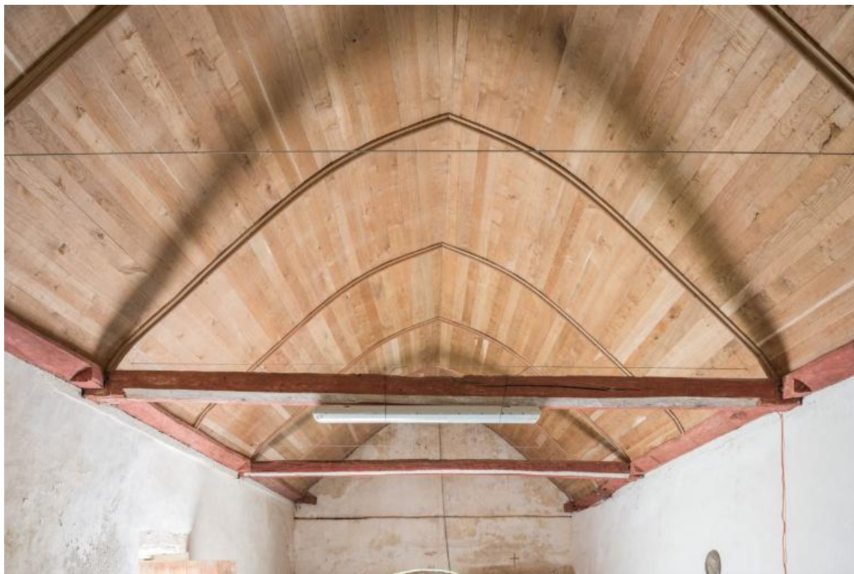
Vue du plafond lambrissée de la nef
